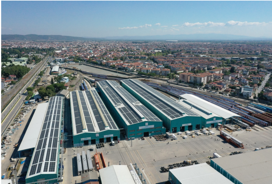
<<< Sakarya Çatı Tipi Güneş Enerji Santrali >>>
